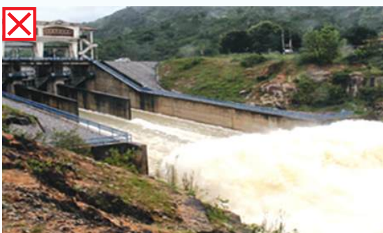
Hồ thủy điện không có biển cảnh báo nguy hiểm, cấm bơi, lội
